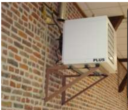
Remplacement des appareils de chauffage
